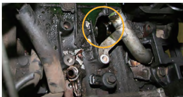
＜エンジンの破損状況＞
